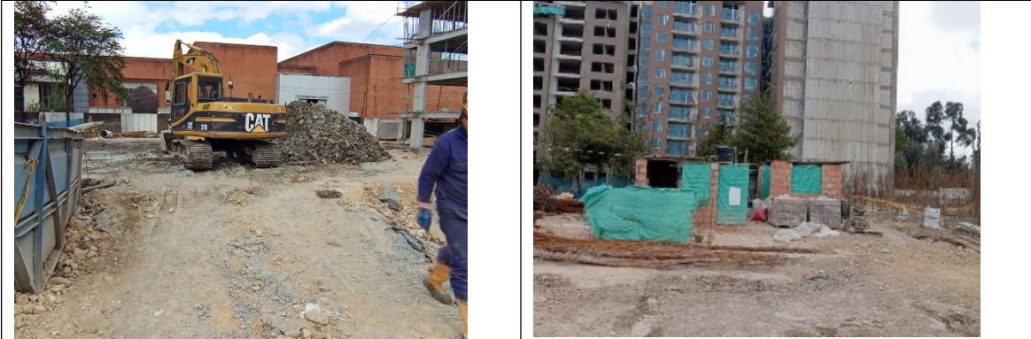
Fotografía 3 y 4. Antiguo tanque subterráneo y subestación eléctrica
