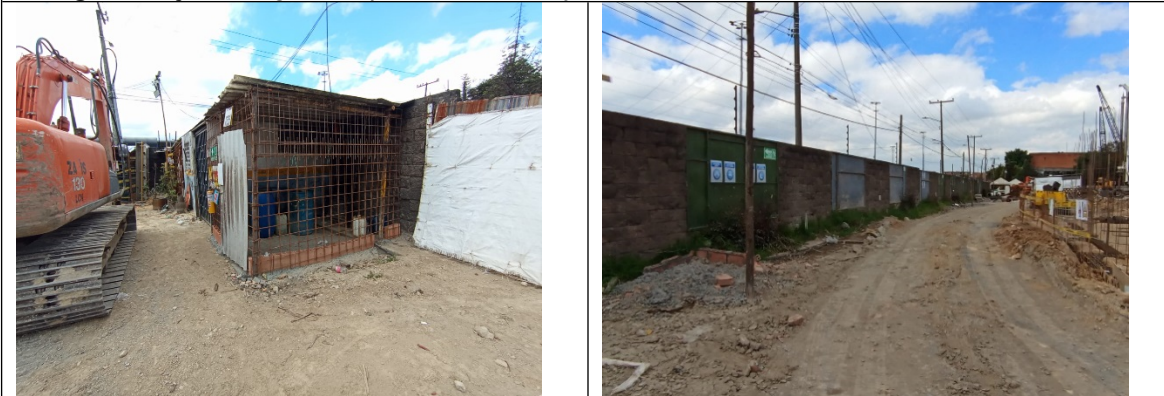
Fotografía 5 y 6. Antigua PTAR y cajas de inspección
